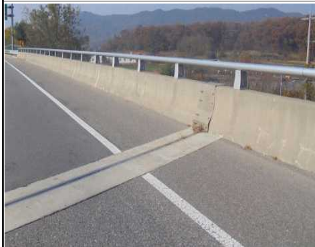
난간 및 연석 전경
